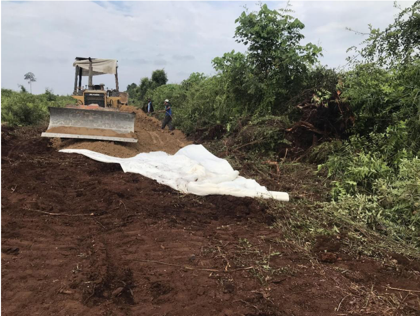
Gambar 19. Alat berat sedang melakukan pembuatan jalan (penimbunan) pada koordinat 101°55'39,144"E 1°8'22,242"N
